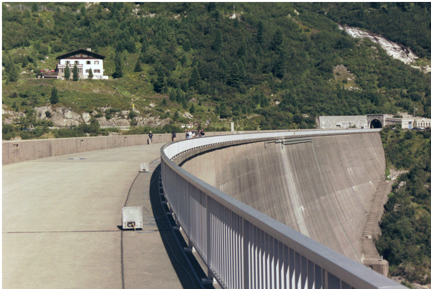
Bild 2. Beschleunigungsaufnehmer auf der Sperrenkrone
