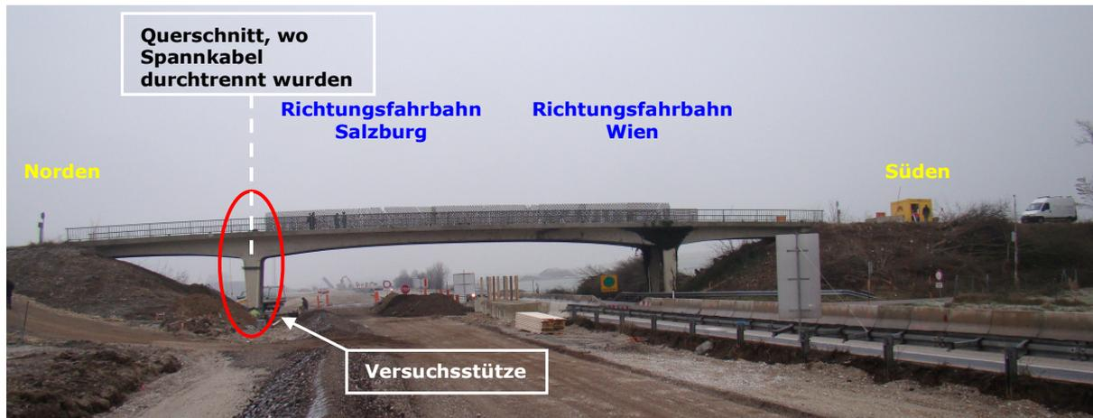
Abb. 3: Versuchsobjekt S101 and der Westautobahn A1 in Österreich
