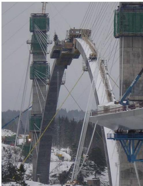
Abb. 2: Bauzustand der Svinesundbrücke in Schweden
