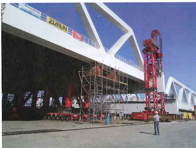
Vormontageplatz: Umsetzen des Stahldecks © VCE Vienna Consulting Engineers ZT GmbH
