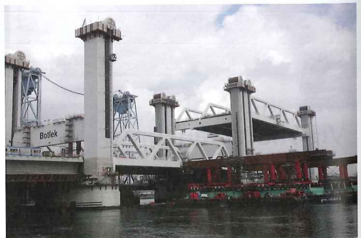
Einschwimmen des vormontierten Stahldecks © VCE Vienna Consulting Engineers ZT GmbH
