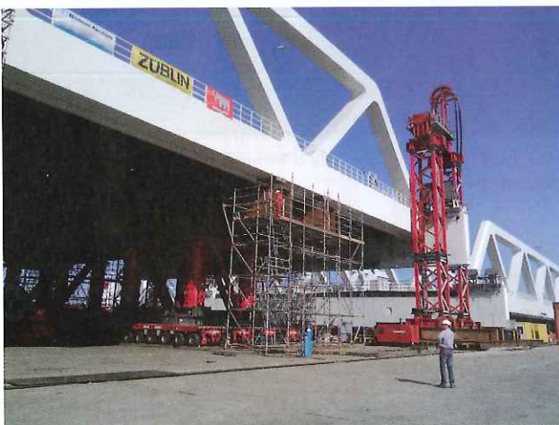
Vormontageplatz: Umsetzen des Stahldecks © VCE Vienna Consulting Engineers ZT GmbH
